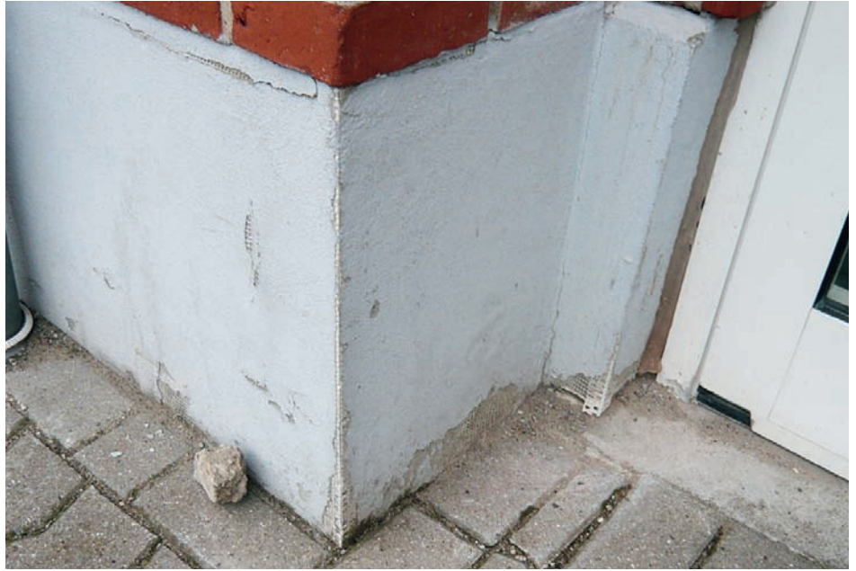
Der gedämmte Sockel – eine wertschöpfende Wartungsbaustelle?
