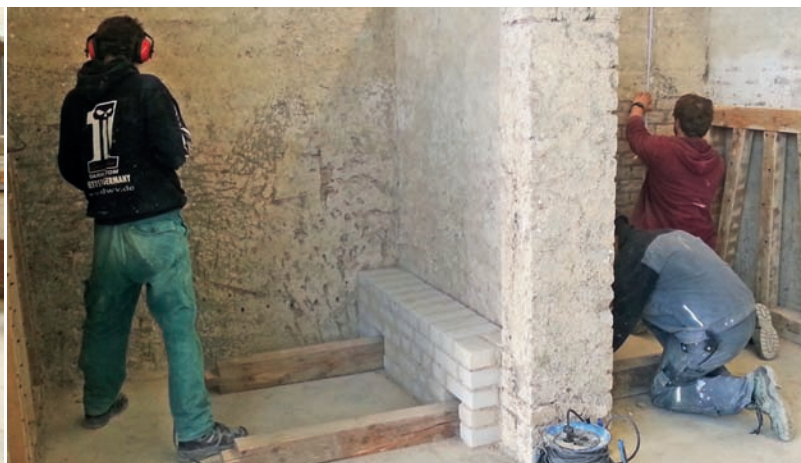
Vorbereitung einer Hausschwammbekämpfung.
