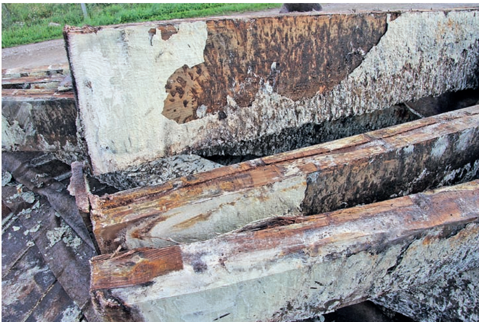
Abb. 4: Fermenter in der Sanierung (oben). Abb. 5: Schwefelablagerungen.
