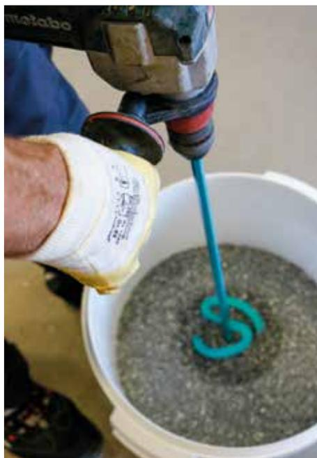
Das zwei-komponentige Bindemittel Hadalan BM2K 12P wird im Verarbeitungsprozess zunächst vermengt und dann mit einem Füllstoff nach Wahl ergänzt.
