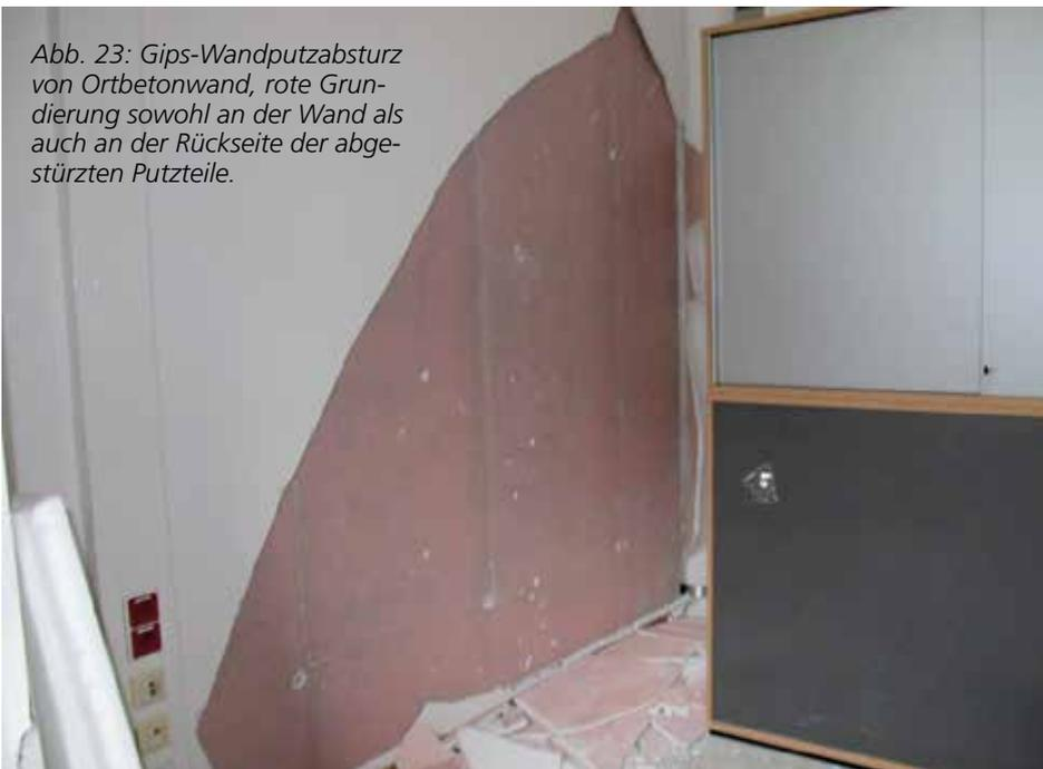
Abb. 23: Gips-Wandputzabsturz von Ortbetonwand, rote Grundierung sowohl an der Wand als auch an der Rückseite der abgestürzten Putzteile.
