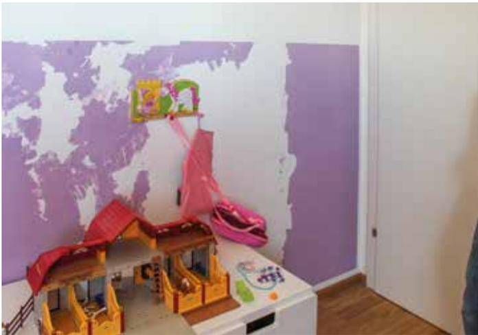
Abb. 13: Großflächige Abplatzungen der Dispersionsfarbe
