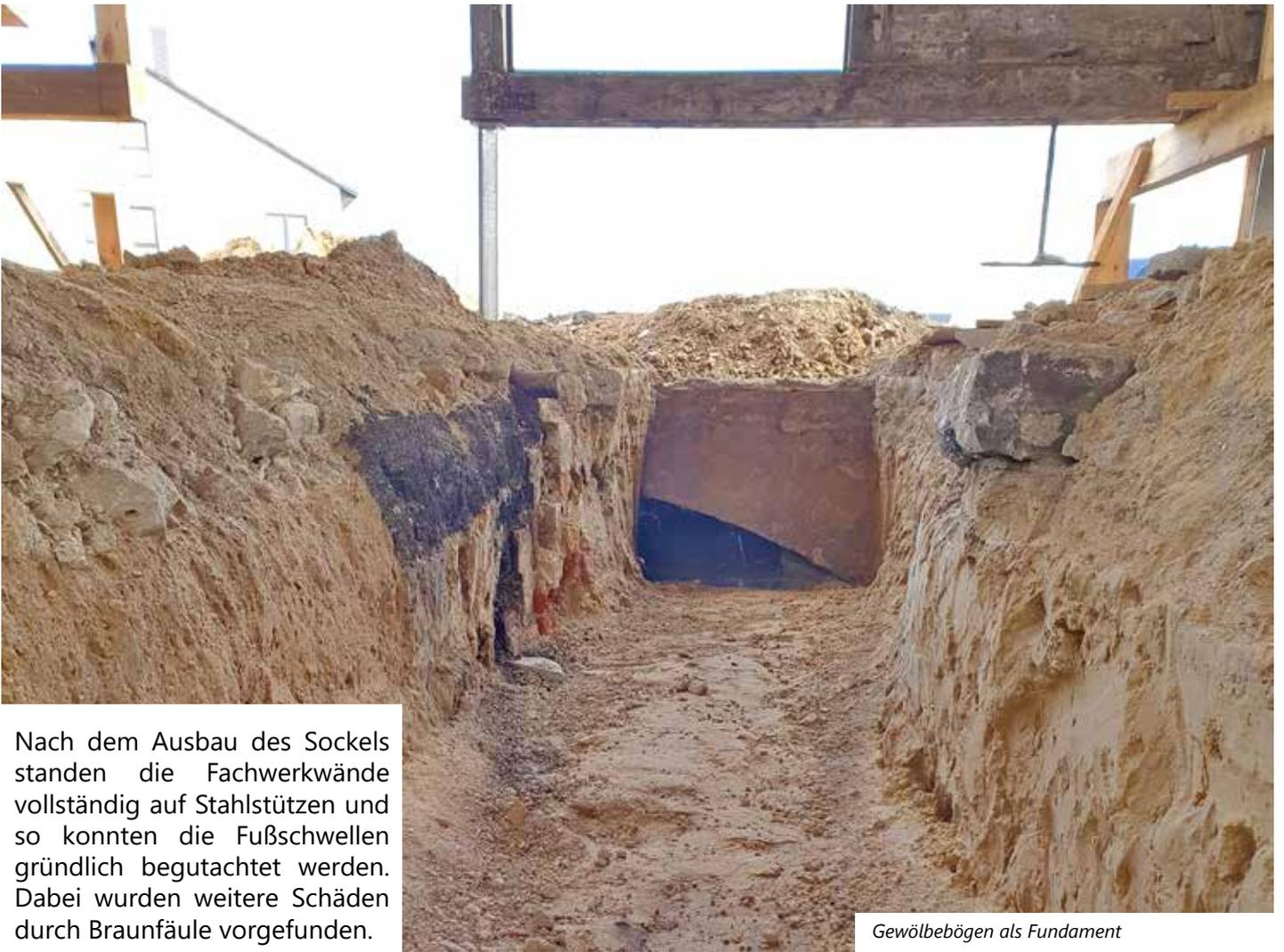
Nach dem Ausbau des Sockels standen die Fachwerkwände vollständig auf Stahlstützen und so konnten die Fußschwellen gründlich begutachtet werden. Dabei wurden weitere Schäden durch Braunfäule vorgefunden.
