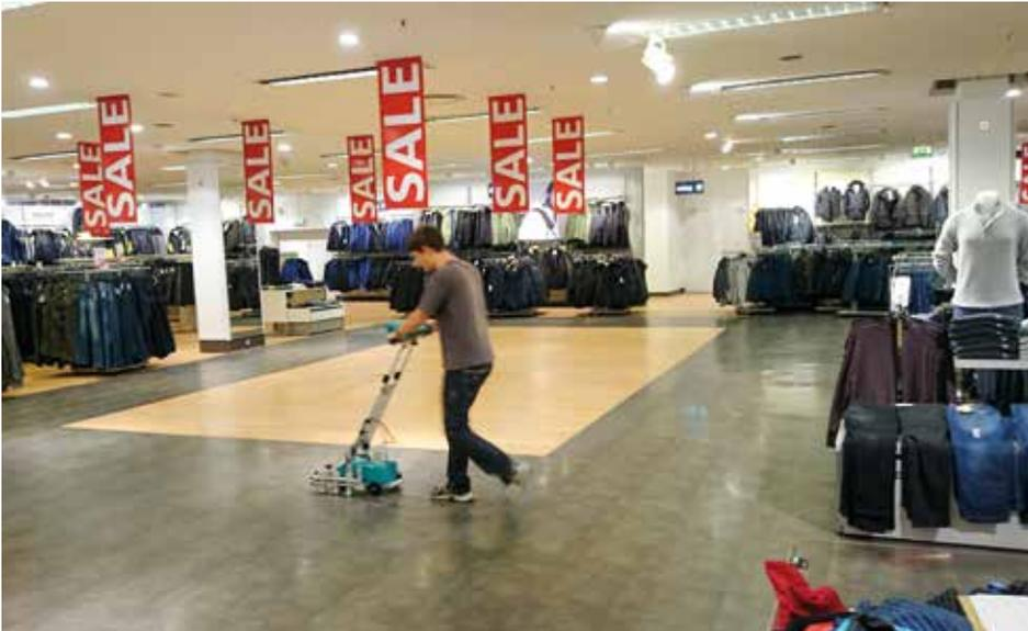
Abb. 6: Feuchtescan im Kellergeschoss eines Kaufhauses
