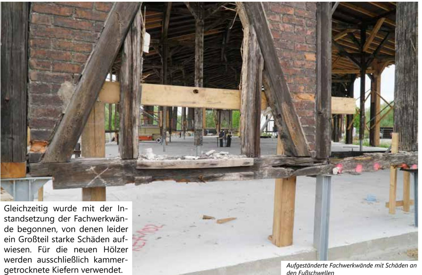
Gleichzeitig wurde mit der Instandsetzung der Fachwerkwände begonnen, von denen leider ein Großteil starke Schäden aufwies. Für die neuen Hölzer werden ausschließlich kammergetrocknete Kiefern verwendet.
