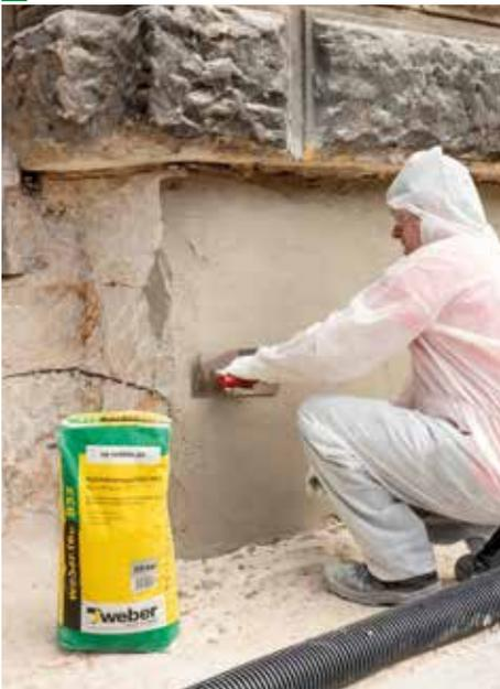
zu schaffen. In jedem Abschnitt mussten die Ausführungsdetails aufs Neue festgelegt werden, da sich nach dem Rückbau stets ein anderes Bild bot. Grundsätzlich aber lässt sich festhalten, dass die vertikalen Dichtungsflächen aus unregelmäßigen Sandsteinquadern, ergänzt mit Ziegelmauerwerk, bestanden. Die horizontalen und geneigten Flächen der Außentreppenbetonfundamente wiesen eine grobe Struktur auf.
