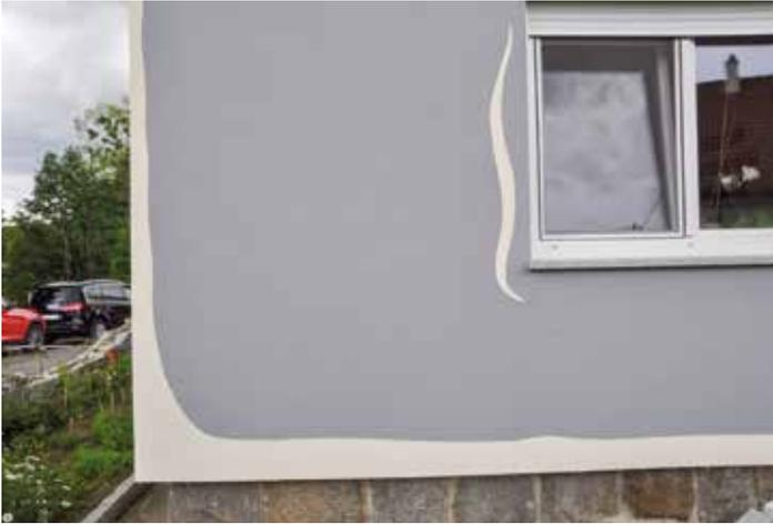
Abb. 5: Mit graublauer Farbe überarbeitete WDVS-Fassade
