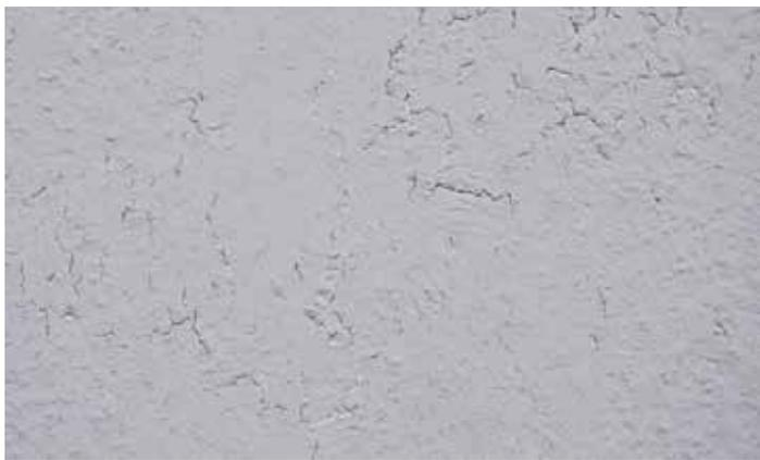
Abb. 6: Craquelee-Risse in der neu aufgetragenen Färbelung
