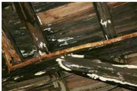
Massive Feuchte- und Pilzschäden
