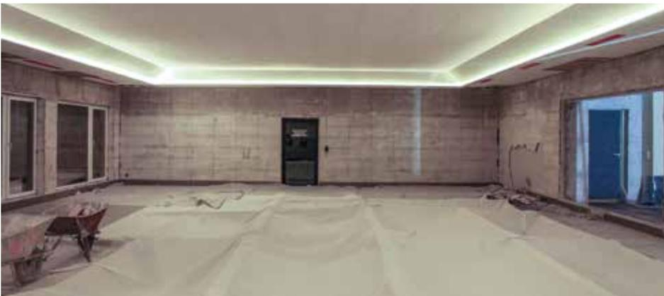
Abb. 11: Zustand nach vollflächigem Abbruch des Fliesenbelages
